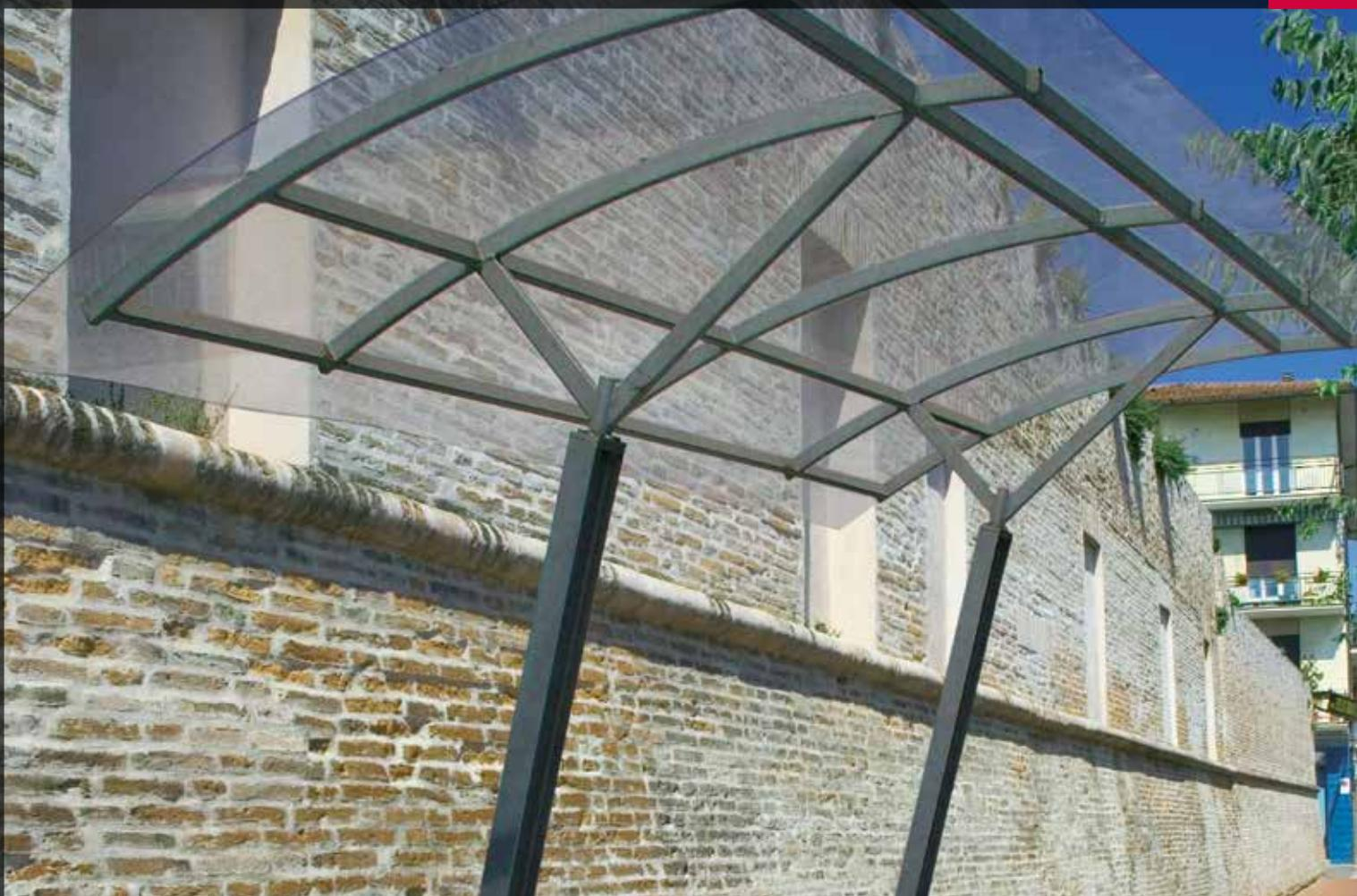
Abri bus réalisé en acier, bois exotique précieux et polycarbonate.
